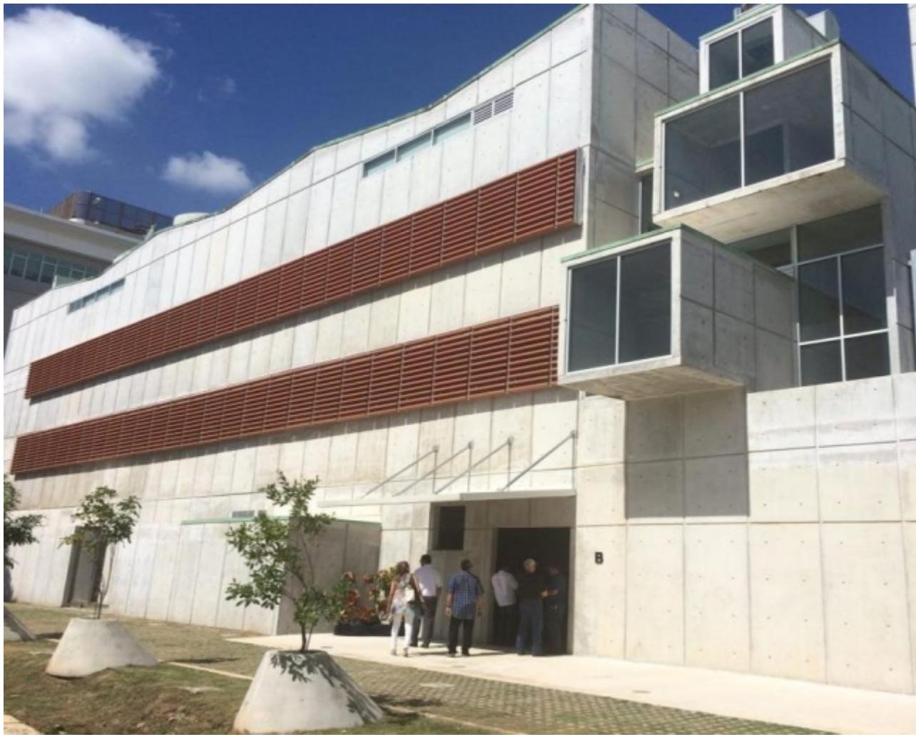
La estructura es principalmente de hormigón expuesto e incluye un diseño de quiebrasoles en los pasillos exteriores, que arrojan sombra al edificio. (Suministrada)
