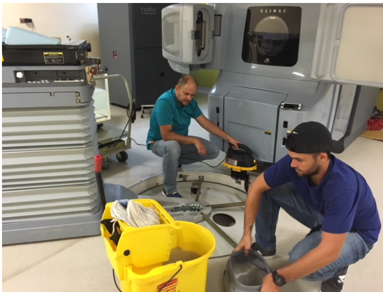
El agua también afectó los equipos médicos en el Centro de Radioterapia del Norte, Arecibo.
