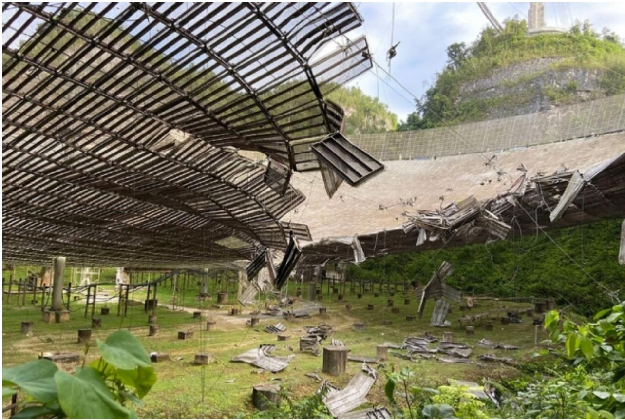
Una sección del plato del **Observatorio de Arecibo** [3], uno de los radiotelescopios más grandes del mundo, sufrió daños en la madrugada del lunes luego que un cable de soporte del módulo transmisor y receptor (Domo Gregoriano), suspendido a unos 492 pies sobre el plato, se rompió.
