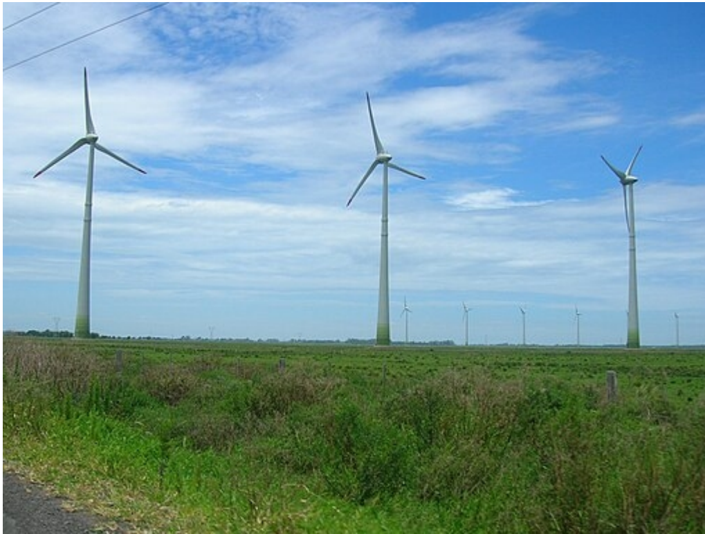
Molinos para generar energía eólica (Erico Rechenmacher)
