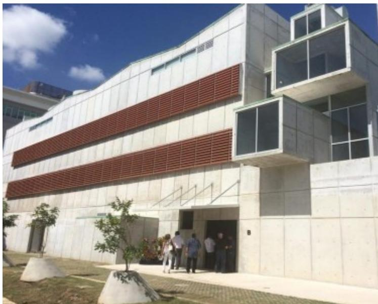
La estructura es principalmente de hormigón expuesto e incluye un diseño de quebrasoles en los pasillos exteriores, que arrojan sombra al edificio. (Suministrada)
