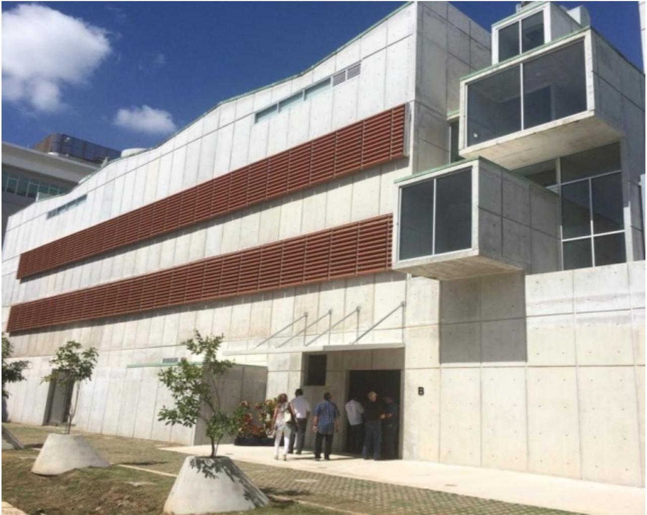
La estructura es principalmente de hormigón expuesto e incluye un diseño de quebrasoles en los pasillos exteriores, que arrojan sombra al edificio. (Suministrada)
