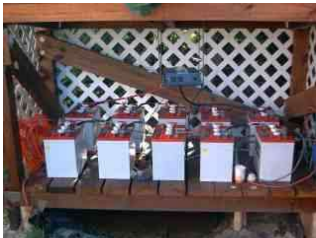
Figura 38 Izquierda. Generador eólico con torre. Derecha. Banco de baterías. Cinco baterías conectadas en serie forman una fila con un voltaje de 27 V y capacidad de 312.5 A-Hr. Las dos filas juntas equivalen a 625 A-Hr. En la parte superior el inversor senoidal. Fotos: Edwin Alfonso Sosa.
